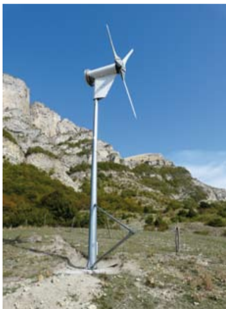
Eolienne de 6 kW dans le sud de la Drôme
