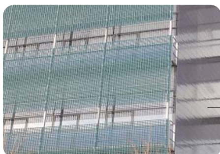
Figure 4 Dispositifs d'ombrage extérieurs pour un bâtiment de bureaux à Dresde en Allemagne.
