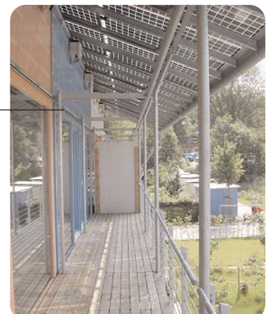
Figure 6 Avancée horizontale (casquette) avec modules photovoltaïques intégrés : maisons solaires à Fribourg en Allemagne.
