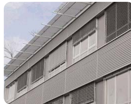
Figure 5 Protections solaires avec une avancée horizontale (casquette) et des stores extérieurs pour un bâtiment de bureaux à Dresde en Allemagne.
