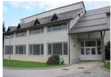
Fig 2) De nouvelles centrales de cogénération ont également été installées dans des bâtiments publics
