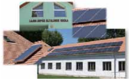
Fig1) Parc énergétique à Szomolya
